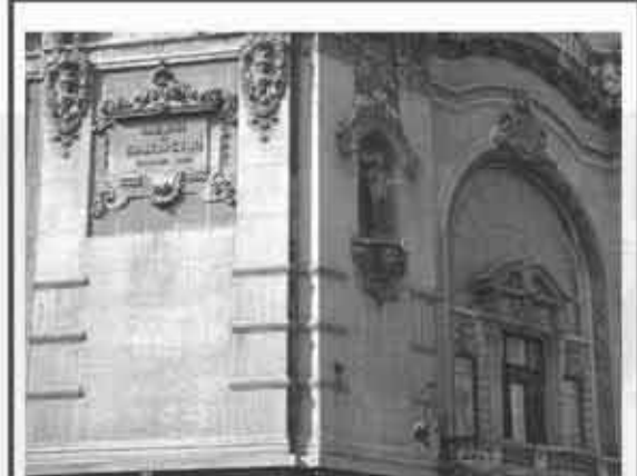
Детаљ на фасади-Београдска задруга
